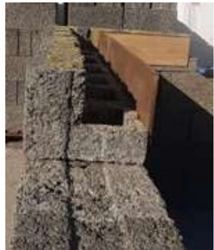
Fig. 4.16 – Debitarea parțială a blocurilor pentru eficientizarea execuției
