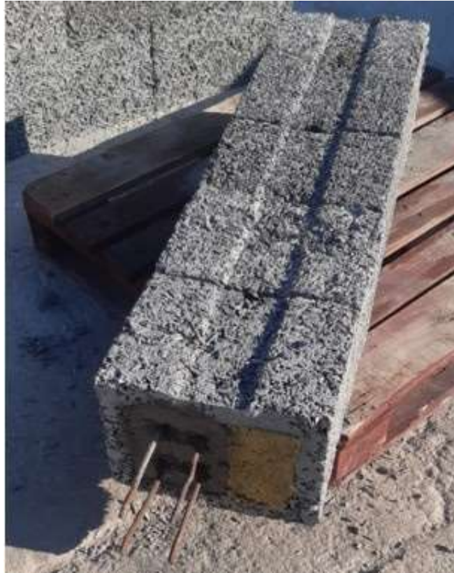
Fig. 4.15 – Utilizarea jumătăților de blocuri pentru cofrarea buiandrugilor
