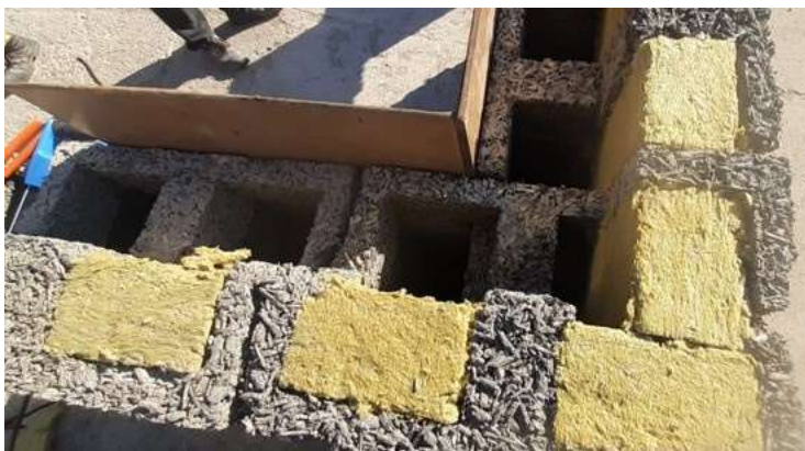
Fig. 4.16 – Debitarea parțială a blocurilor pentru eficientizarea execuției
