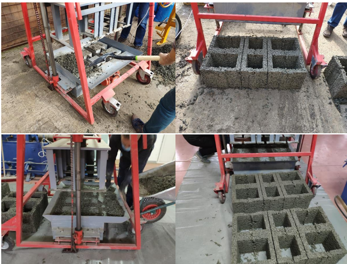
Realizarea blocurilor prefabricate prin vibropresare
